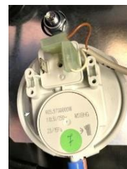
Реле перепада давления воздуха
