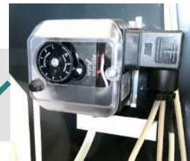
Ограничитель давления дымовых газов 9 мбар
