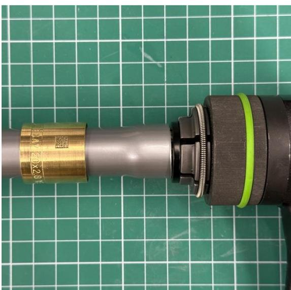
4. Сразу же после расширения трубы фитинг РХ нужно полностью, до упора, вставить в трубу
