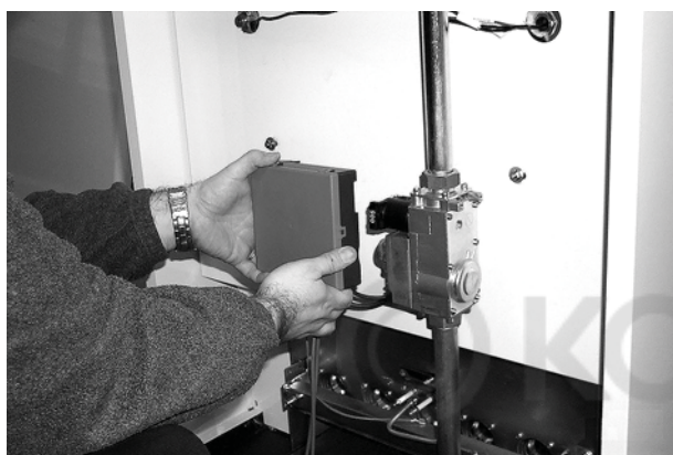
рис. 8 - Снимите блок управления
