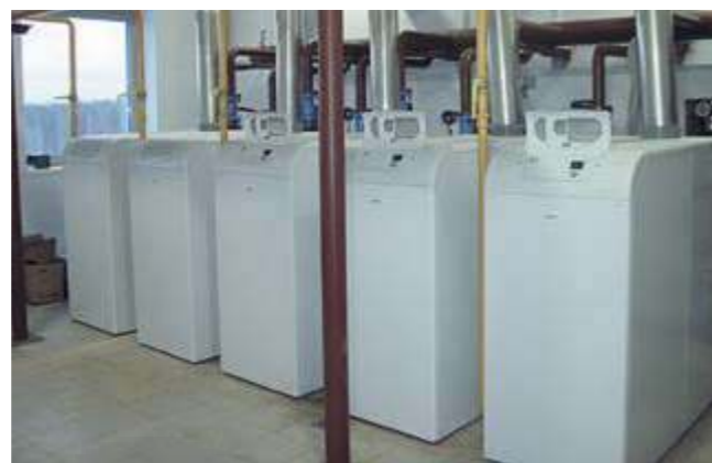
Кинотеатр, г. Йошка-Ола Общая мощность - 1,6 МВт
