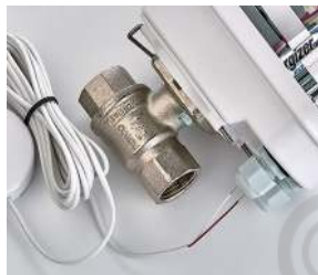
Фото 8. Завести провод датчика в кабельный ввод
