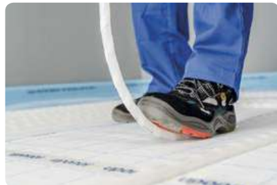
Просто прижмите трубу подошвой к поверхности панели
