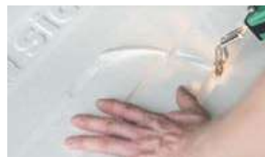
Дополнительные каналы могут быть выпилены электроинструментом
